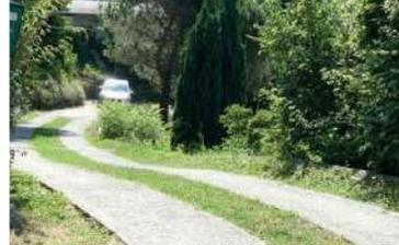
*Bandes de roulement en béton, enherbement central*
